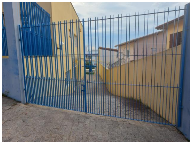
PORTÃO AUTOMATIZADO (ANTES)
